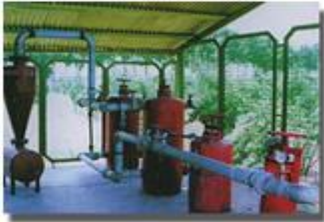
شکل 3: تصویری از طرز قرارگیری تجهیزات در قسمت مرکزی یک سیستم آبیاری قطره‌ای
